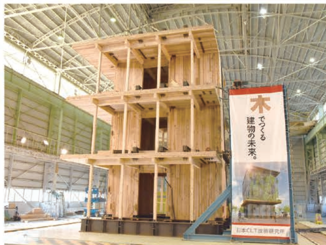
▲新しく開発されたLC-core(エルシーコア)構法
